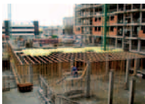
Montaje del encofrado RECUB desde torre móvil
